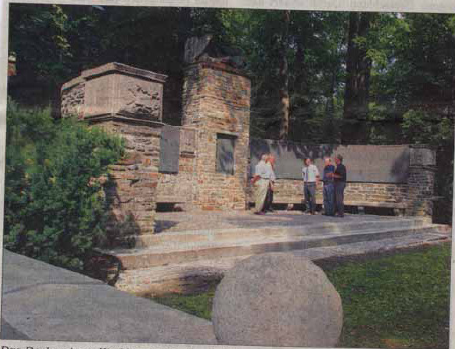
Das Denkmal am Kirchberg in Niederschelden wurde Dank des Einsatzes der beiden Heimatvereine Niederschelden und Niederschelderhütte saniert.
